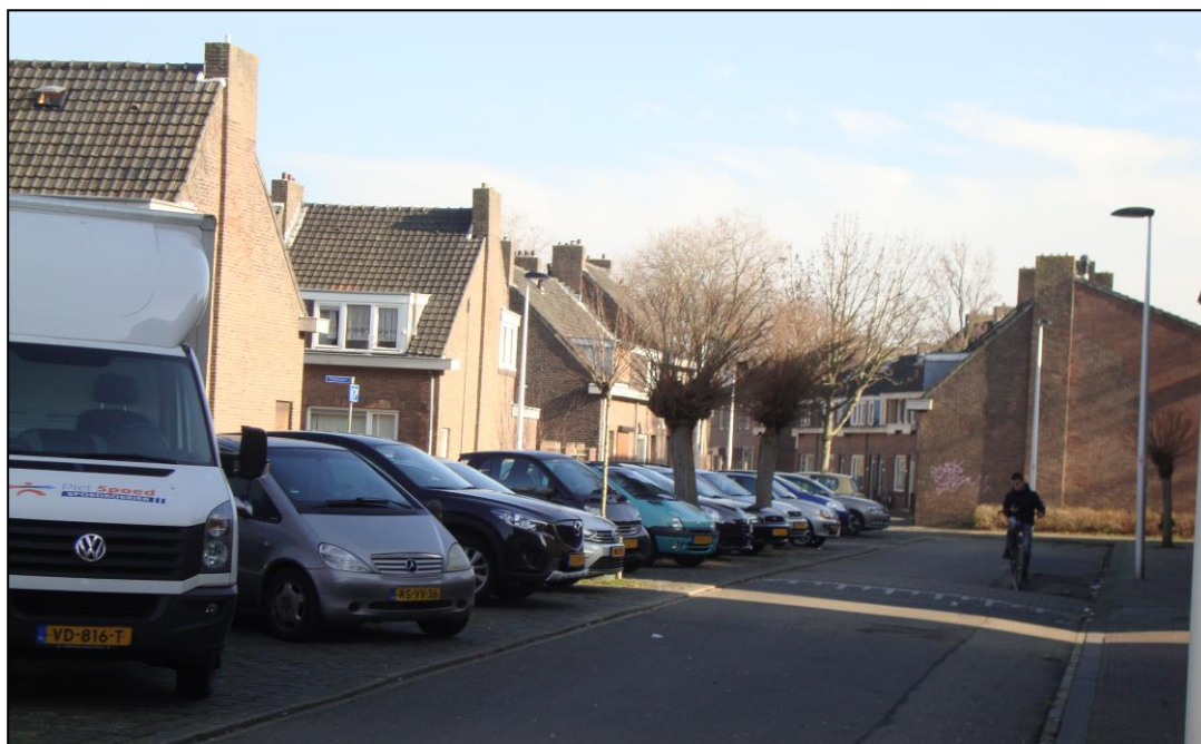
De Stadhoudersstraat in oostelijke richting, met geparkeerde auto's in de middenberm
